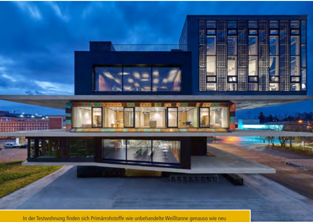
In der Testwohnung finden sich Primärrohstoffe wie unbehandelte Weißtanne genauso wie neu entwickelte Baumaterialien und recycelte Wertstoffe.
