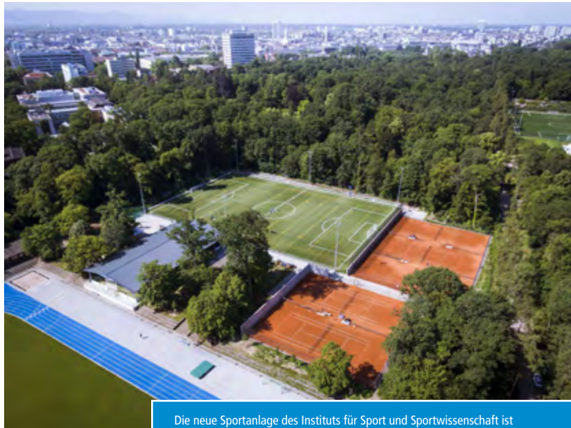
Die neue Sportanlage des Instituts für Sport und Sportwissenschaft ist mit Unterstützung der Stadt Karlsruhe entstanden.
