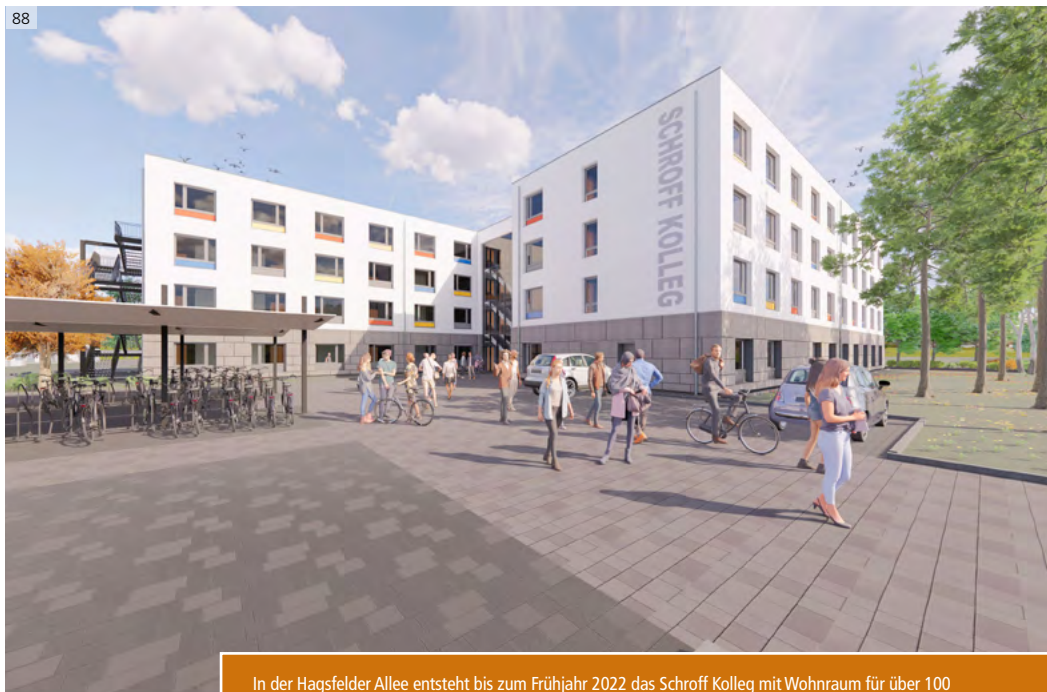
In der Hagsfelder Allee entsteht bis zum Frühjahr 2022 das Schroff Kolleg mit Wohnraum für über 100 Studierende.
