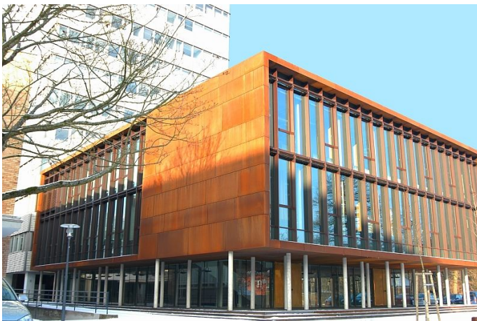
Ende 2008 konnte das neue CFN-Gebäude bezogen werden.
