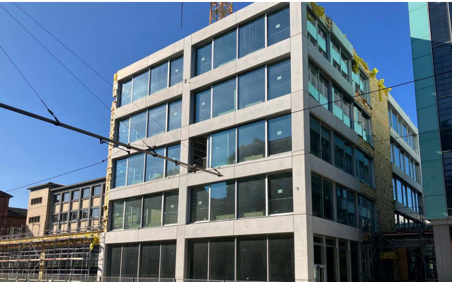
Noch ist es eine Baustelle: Das neue Lern- und Anwendungszentrum Mechatronik am Campus Süd. [147]
