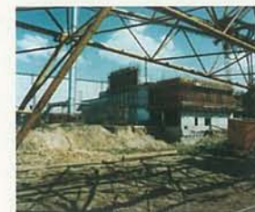
Die WAK während der letzten Bauphase. Die Anlage war Anfang 1971 betriebsbereit.
