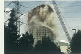
Letzter Akt vor „Grüner Wiese“: Sprengung des HDR-Sicherheitsbehälters.
