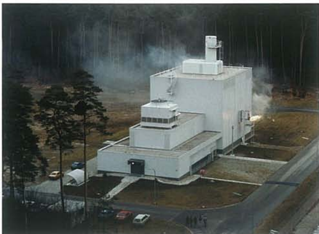
... und in der fertiggestellten Anlage BETA.
